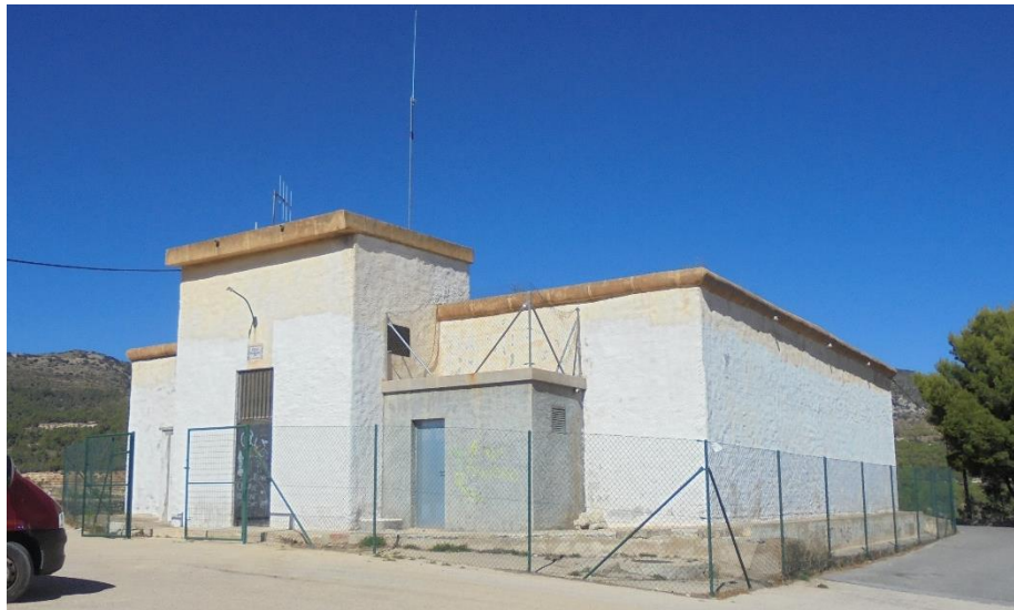
Imagen. Depósito El Mirador.
