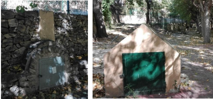
Imagen. Manantial del Parque. Casetas de Registro de la galería.
