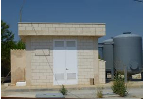
Vista Planta Potabilizadora
