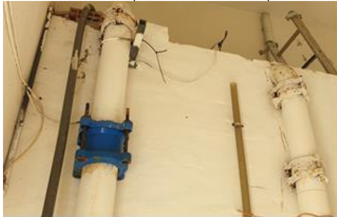
Detalle de acceso a caseta de llaves y tuberías de entrada al vaso.
