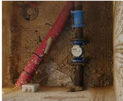
Detalle de instalaciones del pozo Cirerer, brocal y caudalímetro.
