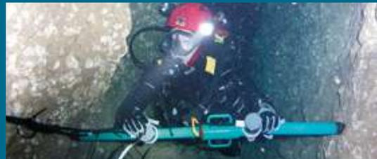
Interior del sumidero de Toix donde se aprecia la sección circular del mismo y un detalle de la instalación de barras de sujeción donde se coloca el caudalímetro equipado por Ciclo Hídrico de la Diputación de Alicante
