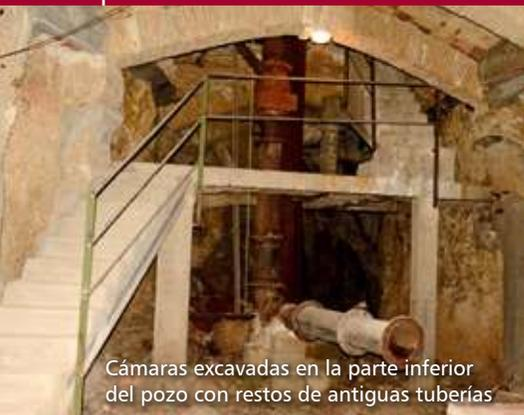
Cámaras excavadas en la parte inferior del pozo con restos de antiguas tuberías
