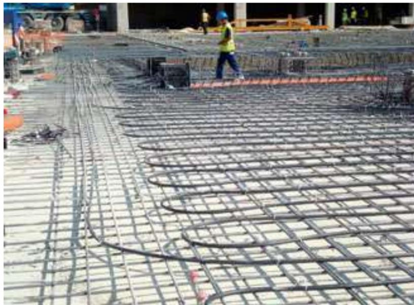
(b) Losa de cimentación con capacidad de intercambio geotérmico
