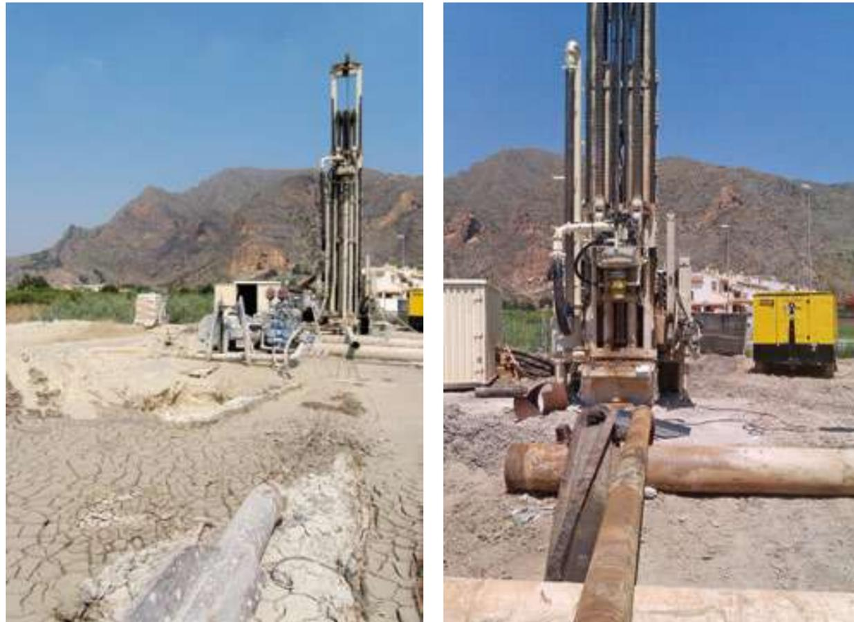
Perforación del sondeo de investigación Caracalla de aguas termales, en Callosa de Segura, ejecutado por Ciclo Hídrico. Este sondeo de 349 m de profundidad capta agua del acuífero de Sierra de Callosa a 33,8°C
