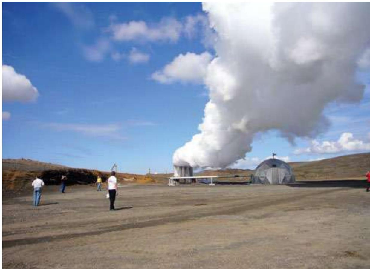
Prueba de producción de sondeos geotérmicos en la planta flash de Hellisheidi, Islandia
