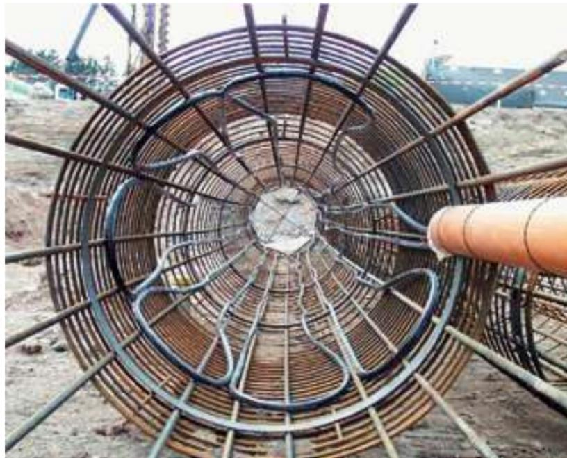
(a) Vista axial de un pilote activado con sondas geotérmicas
