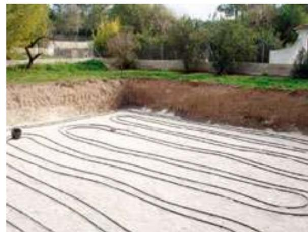
Intercambiador horizontal en bucles de tipología slinky horizontal.
