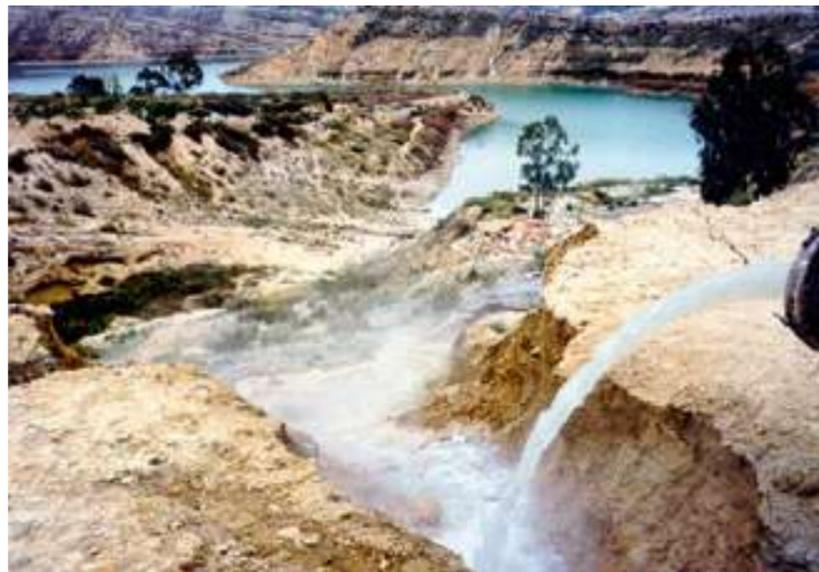
Este pozo alcanza los 721 m de profundidad y capta agua del acuífero Sancho. Se registran 45°C de temperatura del agua en boca de pozo
