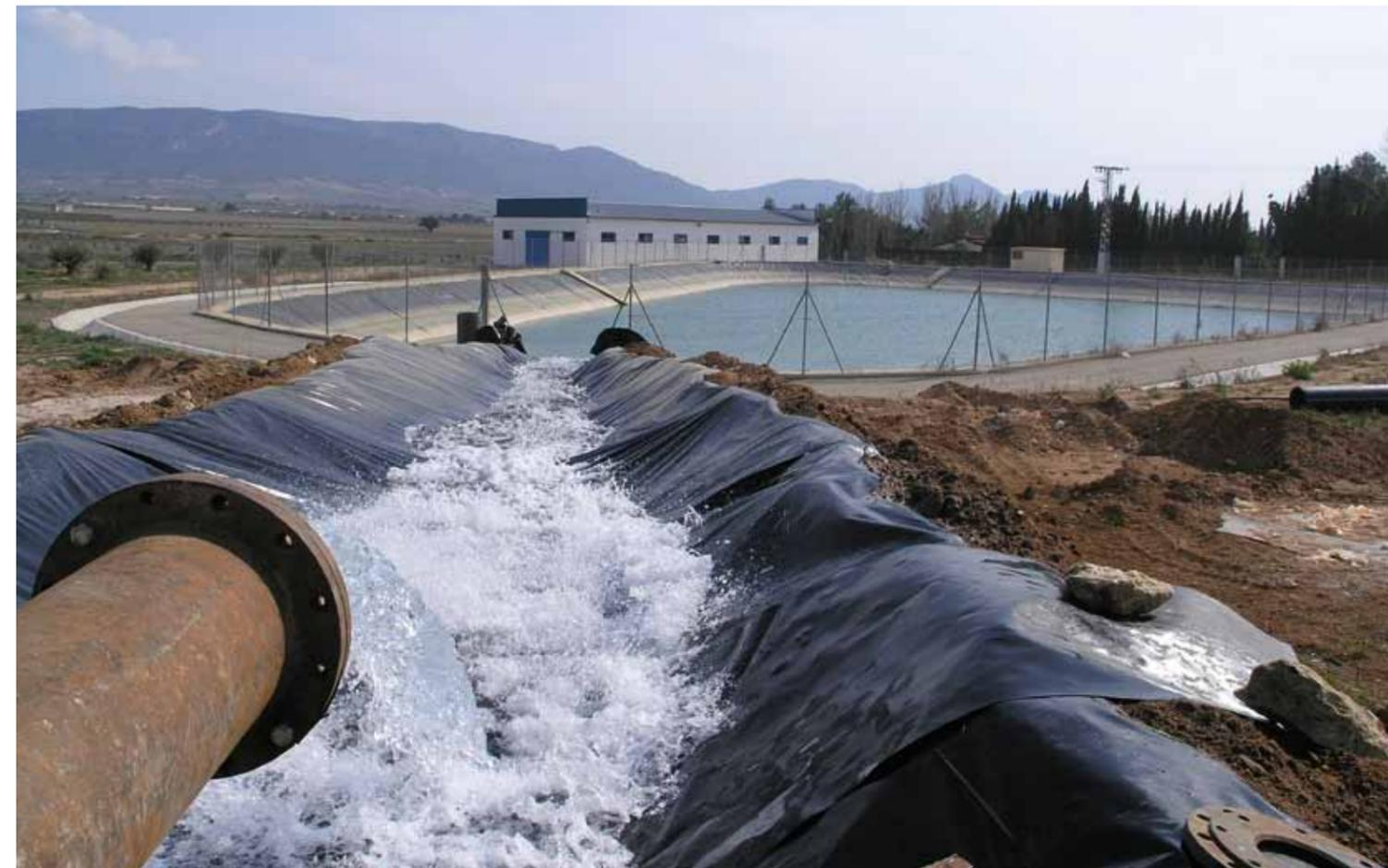
Ensayo de bombeo del Pozo Candela y almacenamiento en balsa de riego
